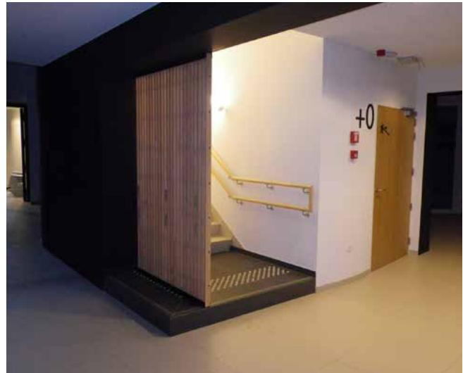
**Fotografija:** Stepenice su opremljene dvostrukim neprekidnim rukohvatom i odgovarajućim osvetljenjem. Kontrastne boje i taktična obeležja privlače pažnju na stepenice. (© TGB, 2013)
